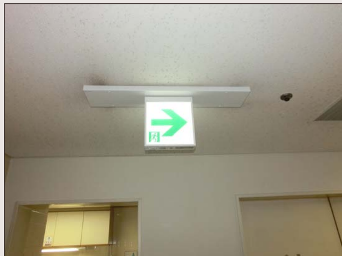
通路誘導灯20WからLEDへ、リニューアル工事。
