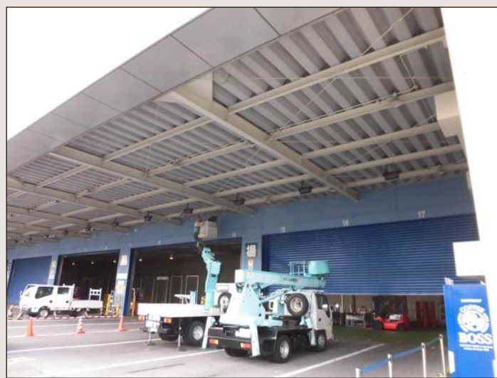
高所作業車で配管工事入線後、感知器取付工事中。
