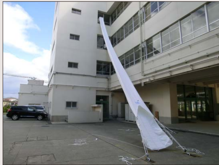
大阪府立高校の救助袋の取替工事後。
