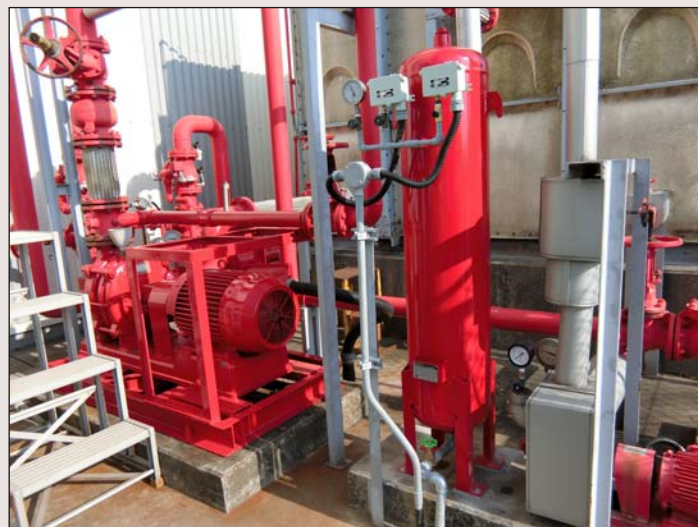
スプリンクラー設備圧力タンクの取替工事。
