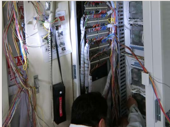
自立型100回線火災受信機2台取替後、配線結線中。
